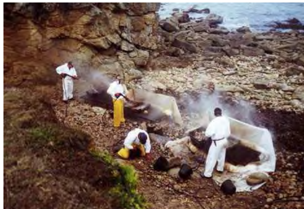
Lavage de galets sur site (Source : Cedre)
