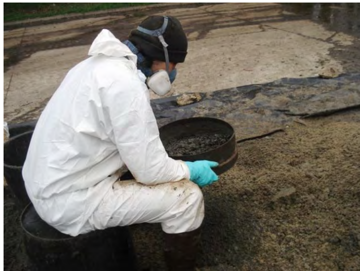
Criblage manuel du sable (Source : Le Floch Depollution)
